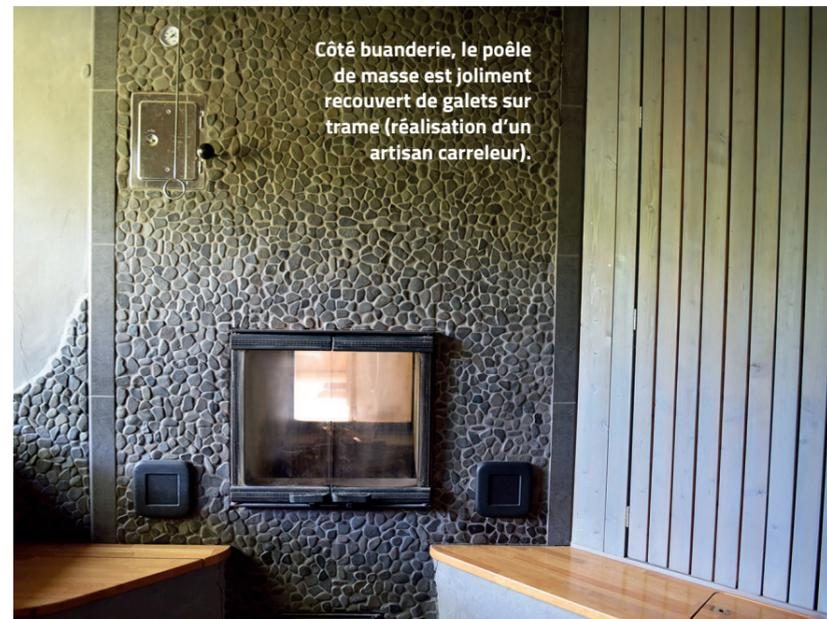
Côté buanderie, le poêle de masse est joliment recouvert de galets sur trame (réalisation d'un artisan carreleur).
